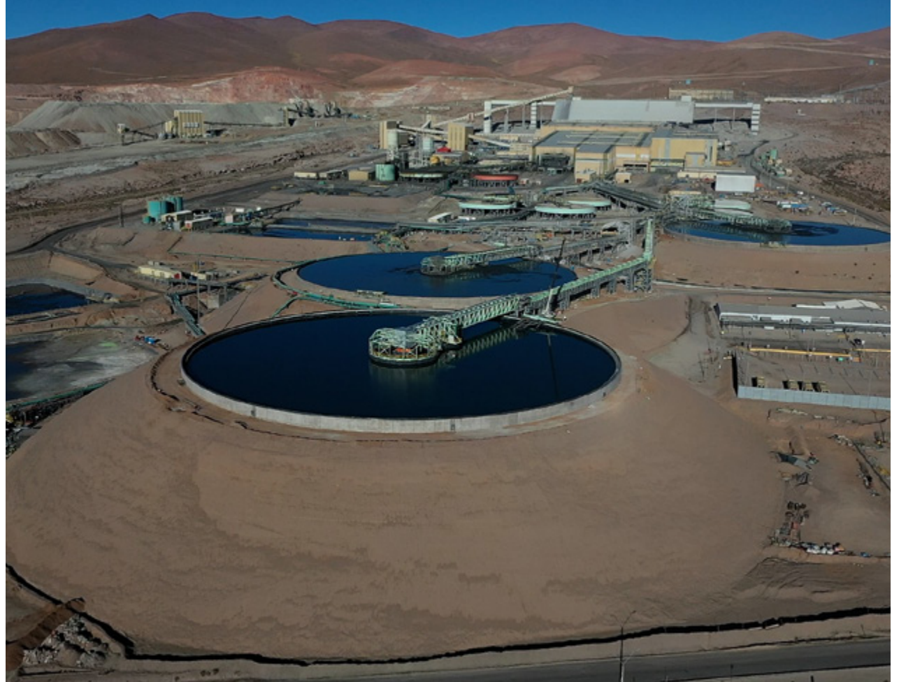
Tercer espesador de alta tasa, HRT, recientemente construido, Faena Cordillera.
